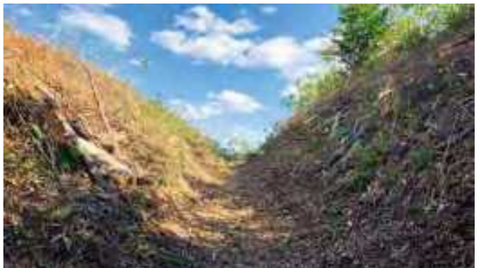
西側に位置する郭には大きな土塁と空堀が。V字形に掘られた薬研堀の傾斜はキツく、深さが6mもある
